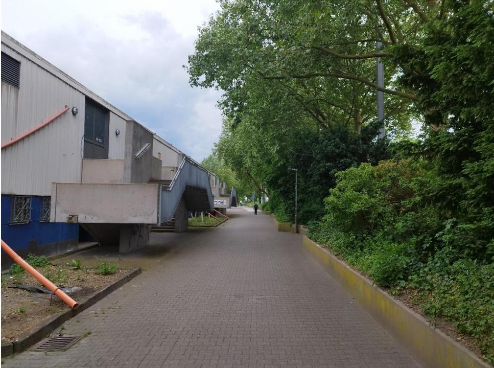
**Abbildung 3-5: Westseite der Eishalle mit Zugängen. Auf dem Bild sieht man ebenso die Trapezblechverkleidung der Halle**
