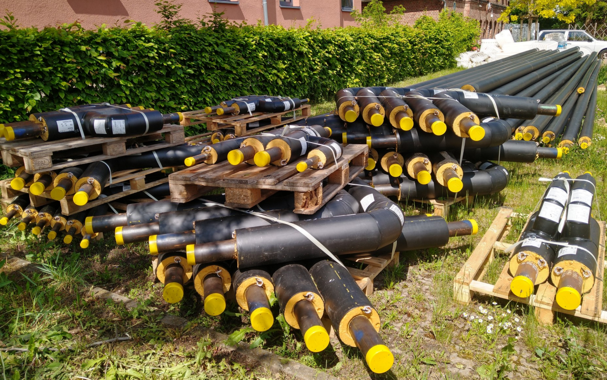
Abbildung 1: Fernwärmerohre vor der Verlegung. (eigene Aufnahme ZRK)
